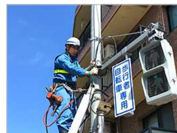
【信号灯器取替中】
