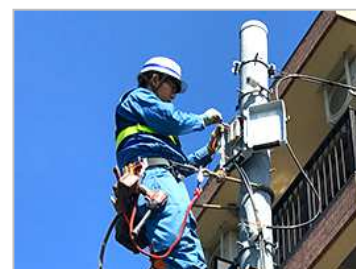
【制御線接続中】
