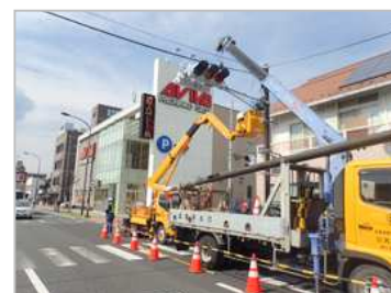
【車両灯器取替作業】
