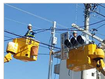
【信号灯器取替中】
