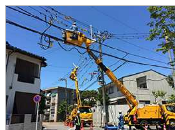
【高圧線張替作業中】
