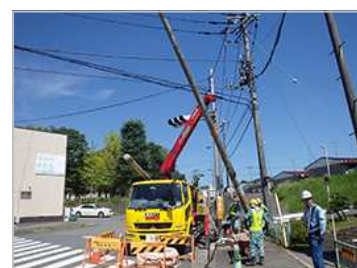
【信号柱の撤去】
