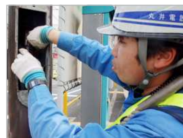
【制御線接続中】
